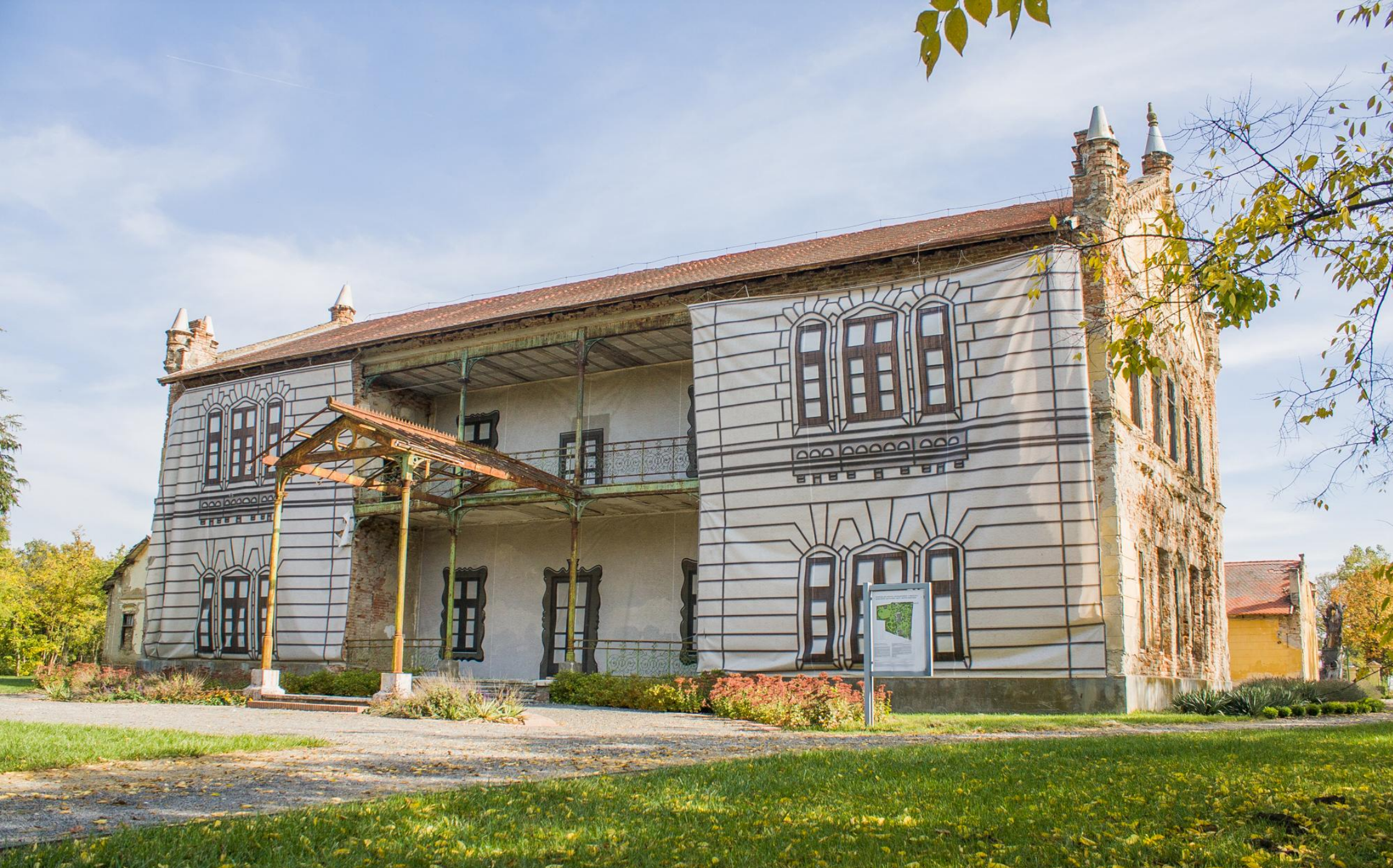
Főhomlokzat a korai öntöttvas oszlopos lodzsával
