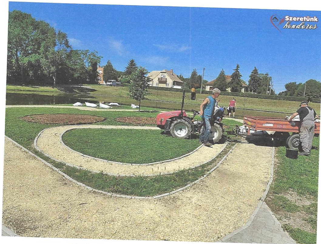
17. kép - Sziget kiépítése 2021.05.27.- (Fotó: Bankó Tamás)
