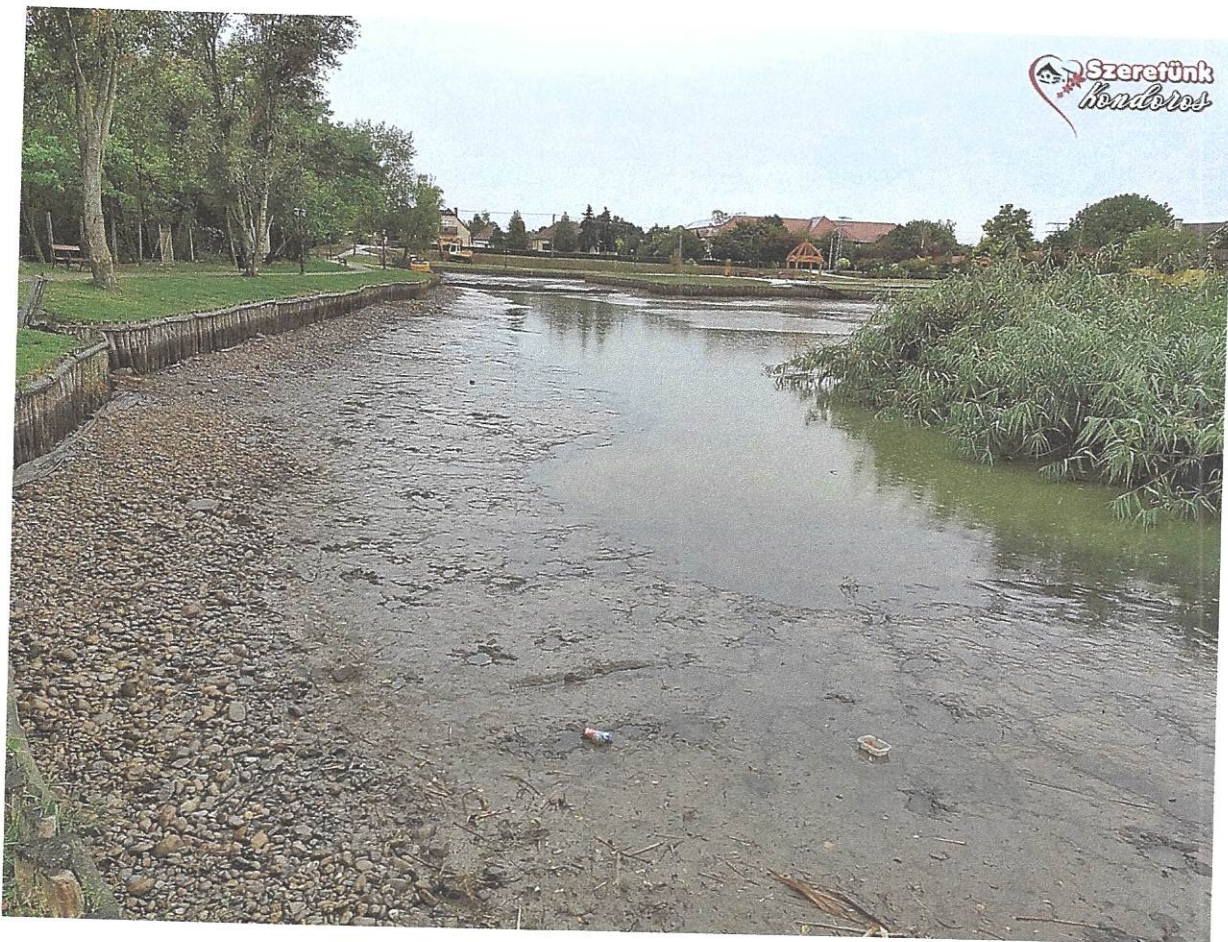
20. kép - Iszapkotrás 2021. 09.21. - (Fotó: Bankó Tamás)
