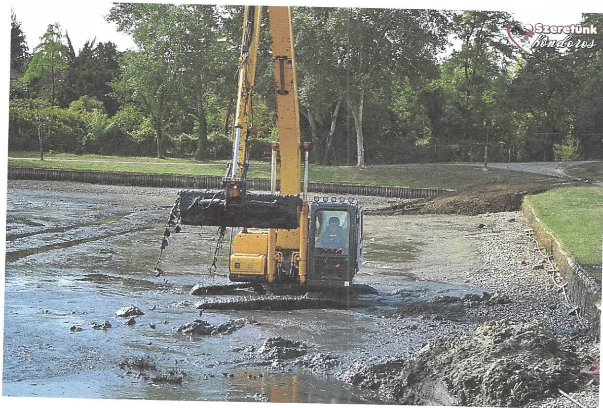
21. kép - Iszapkotrás 2021.09. 21. - (Fotó: Bankó Tamás)
