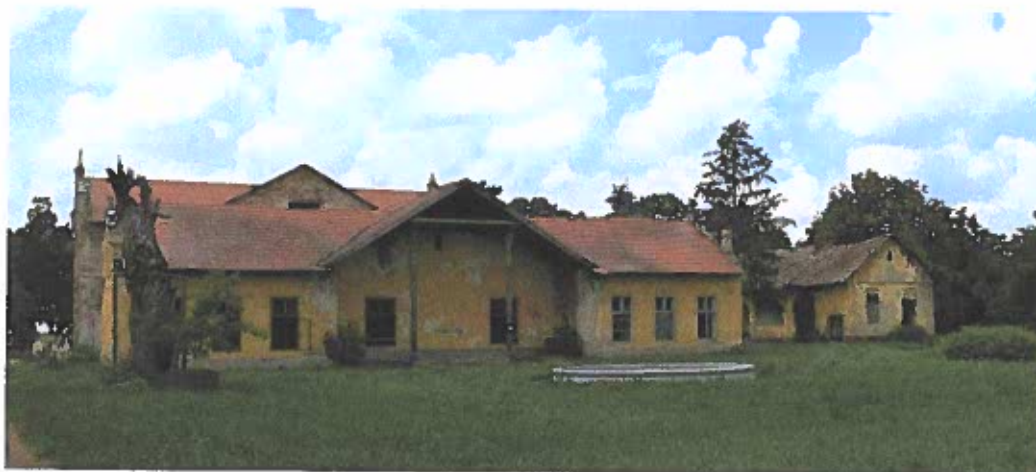
26. kép A svájci stílusú keleti épületrész, felújított díszkúttal – anno tisztartói kúria
