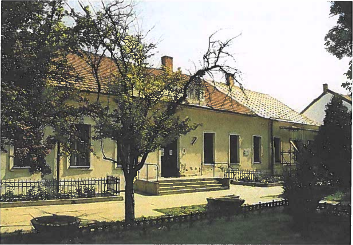
27. 1997. tetőcsere közben és után
